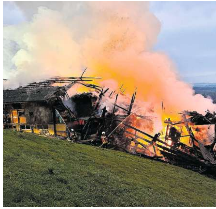
Der Stall stand in Vollbrand, das Übergreifen des Feuers auf das Wohnhaus konnte aber verhindert werden. Bild: Kapo SG
