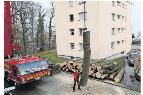
Mit einem faltbaren Pneu-Kran werden Baumstämme aus dem Mühlebach Tobel hochgehoben.
