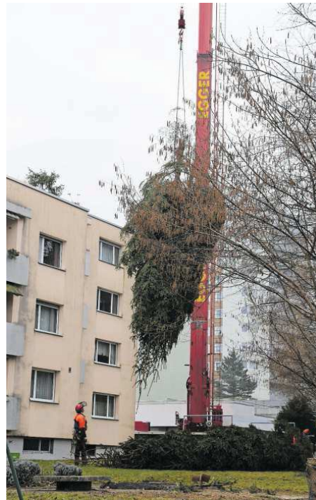
Die Arbeit nahe an Wohnhäusern ist schwierig und erfordert von den Forstarbeitern Präzision. Bilder: Jolanda Riedener
