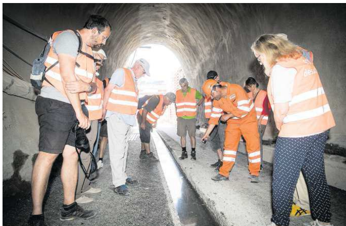
Tag der offenen Baustelle im Bruggwaldtunnel.
