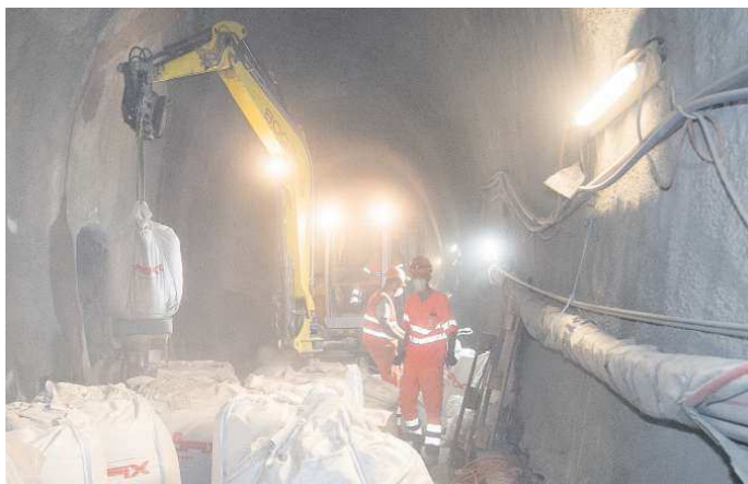
Der aufgewirbelte Staub schränkt die Sicht im Tunnel ein.
