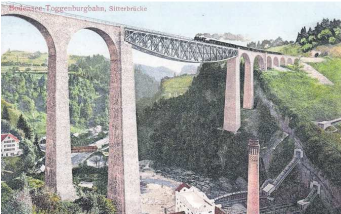
Das Sitterviadukt der Bodensee-Toggenburg-Bahn (BT, heute SOB) entstand von 1907 bis 1910. Es war damals die höchste Brücke der Schweiz und galt als technische Meisterleistung. Darunter liegt das Kraftwerk Kubel.
